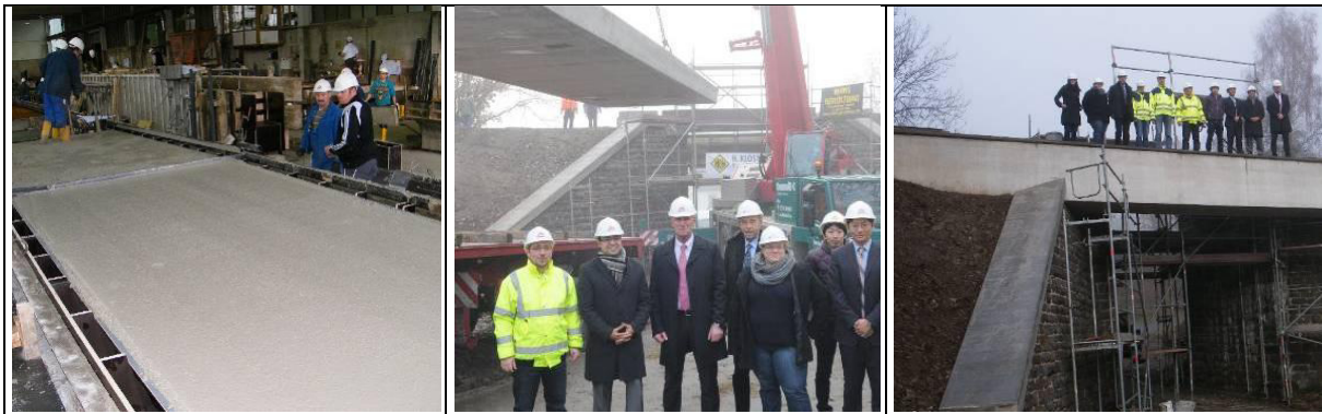
Bild 1a-c: Betonfertigung bei der Fa. Runkel am 05.11.2012 und Montage der Brücke Rosenthal am 14.11.2012 in Olpe
